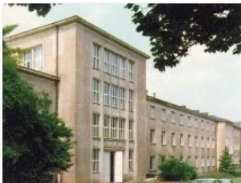
Pilot- und Demonstrationsanlage „Merkel-Bau“
