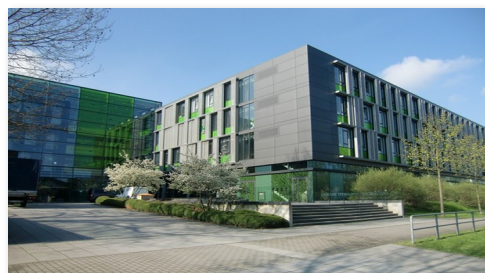
Ungekühlter Referenzfall „Andreas-Pfitzmann-Bau“
