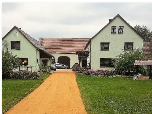
Feldtestanlage „Dreiseitenhof“ (Kühlung über Grundwasser)
